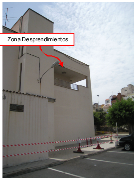
Lateral derecho –Parking descubierto
