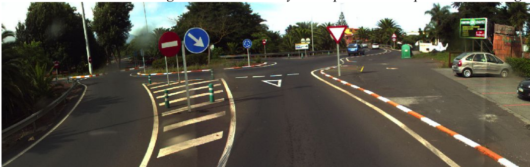
Imagen nº 1 Vista del lugar donde se produjo el incidente dañoso Pk 4+153 de la TF-152.
