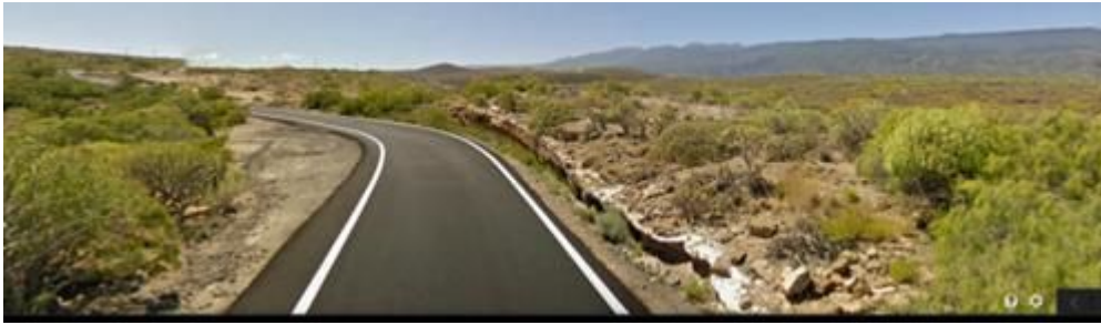
Zona nuevo acceso a pista nueva para llegar a apoyo 111-17
