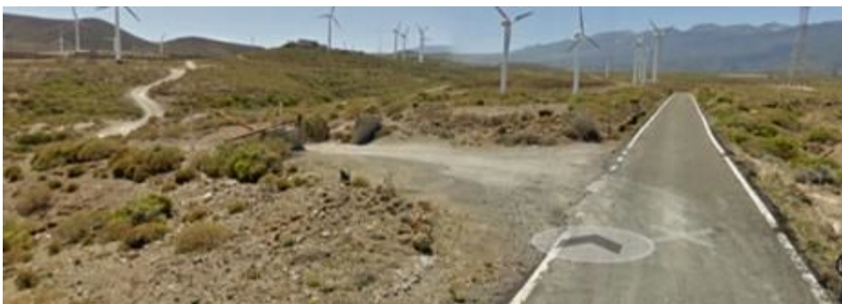
Acceso desde la 627 a apoyos 111-19 y 119-20
