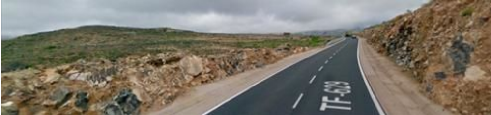
Zona de nuevo acceso desde TF-629 a apoyo 111-9
