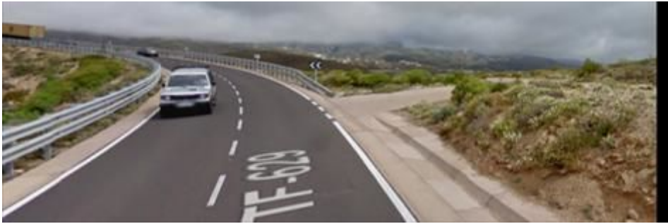
Acceso al apoyo 111-10 desde TF-629
