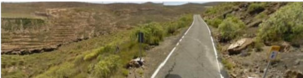
Zona nuevo acceso de nueva pista para apoyo a 111-12
