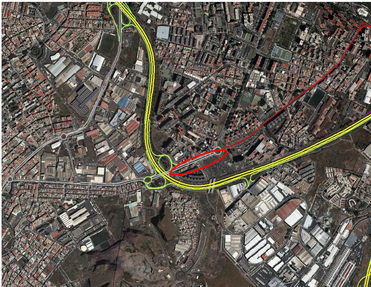
Tramo traspasado de acuerdo con el acta de recepción de 31 de enero de 2007. TF-192, del PK. 1,500 al PK. 1,857”
