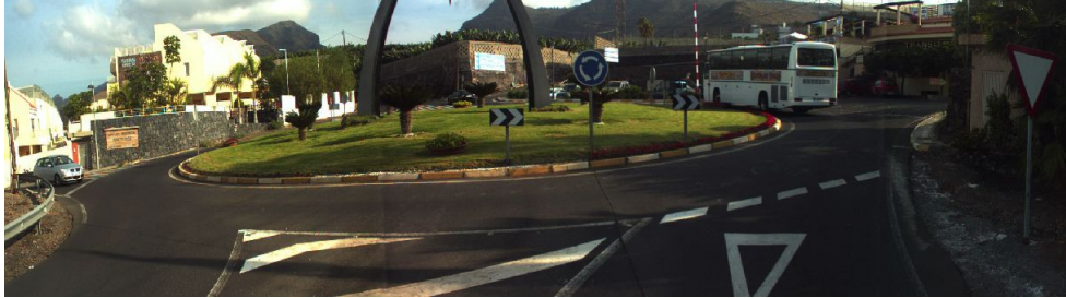
Imagen nº 1 Vista de la ubicación de la glorieta objeto de la afección situada en el Pk 18+675 de la TF-47.
