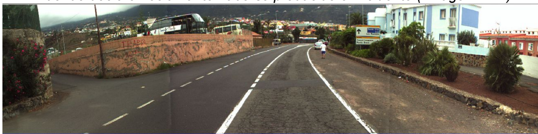
Imagen nº 1 Ubicación aproximada de la incidencia a la altura del Pk 3+813 de la TF-320.
