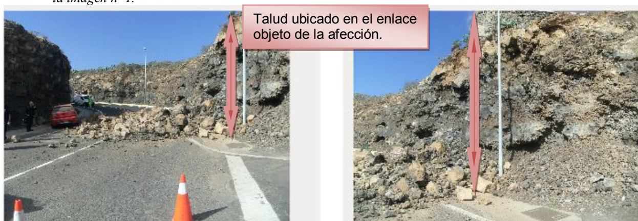
Imagen nº 1 Vista del enlace de la TF-1 situado a la altura Pk 66+700, donde se produjo el desprendimiento..
