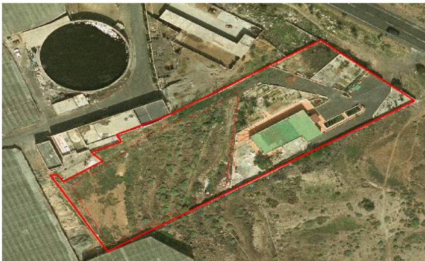
Vista aérea del terreno sobre el que se proyectan las instalaciones
