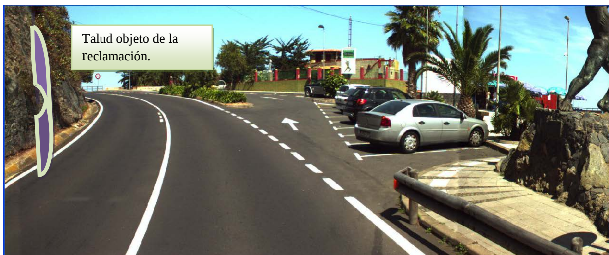
Imagen nº 1 Vista del lugar donde se produjo el incidente dañoso a la altura del Pk 5+180 de la TF-342.
