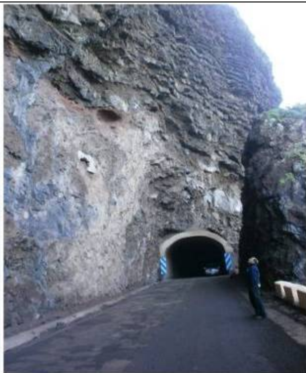
Zona 12. Tramo en trinchera antes del túnel.
