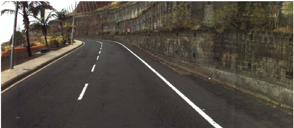
Imagen nº 1 Vista del lugar donde se produjeron los hechos coincidente con el Pk 16+700 de la TF-13
