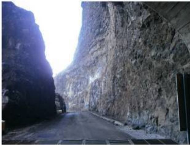
Panorámica de la Zona 12 tomada desde el túnel.
