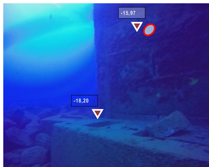
Imagen 13. Punto aproximado de salida de la perforación. Fuente: CIVILPORT Ingenieros, S.L.U.
