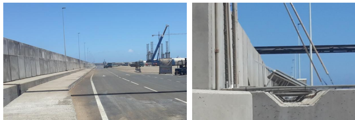
Imágenes 45 y 46. Bloques en coronación de talud de protección (izqda.) y detalle de machihembrado (dcha). Fuente: CIVILPORT Ingenieros, S.L.U.
