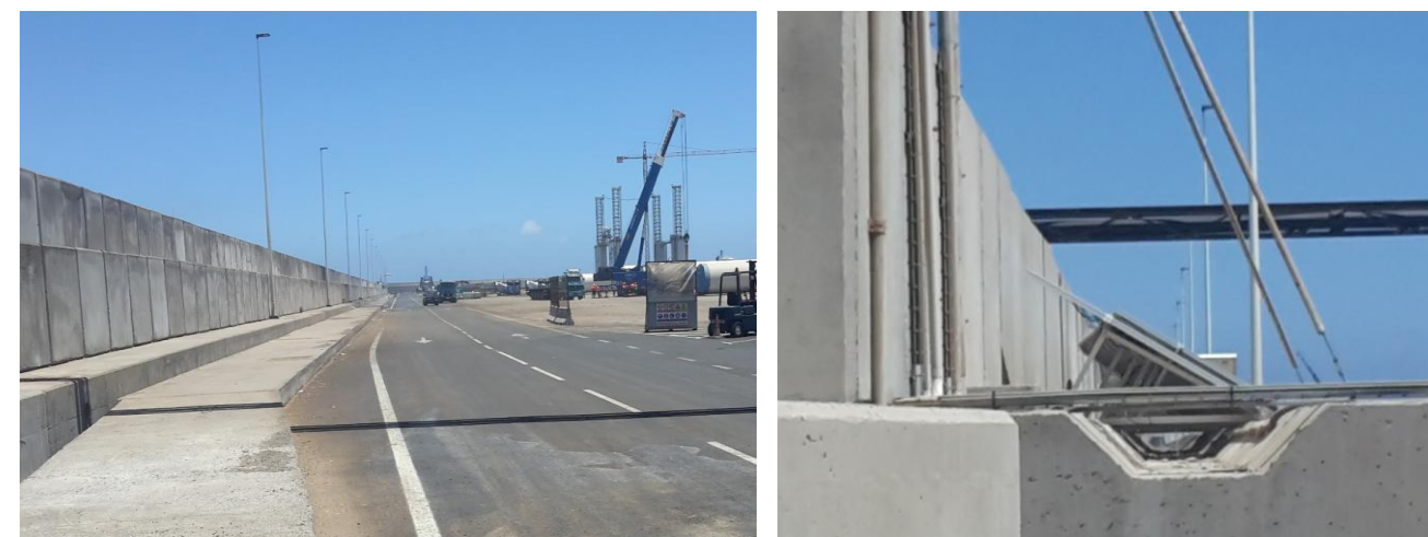
Imágenes 11 y 12. Bloques en coronación de talud de protección (izqda.) y detalle de machihembrado (dcha). Fuente: CIVILPORT Ingenieros, S.L.U.
