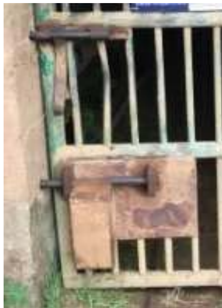
Figura 2-2. Detalle de los mecanismo de cierre de la puerta de la bocamina
