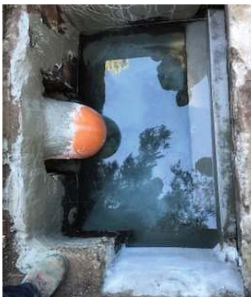
Figura 2-7. Detalle del vaso de entrada a la tanquilla
