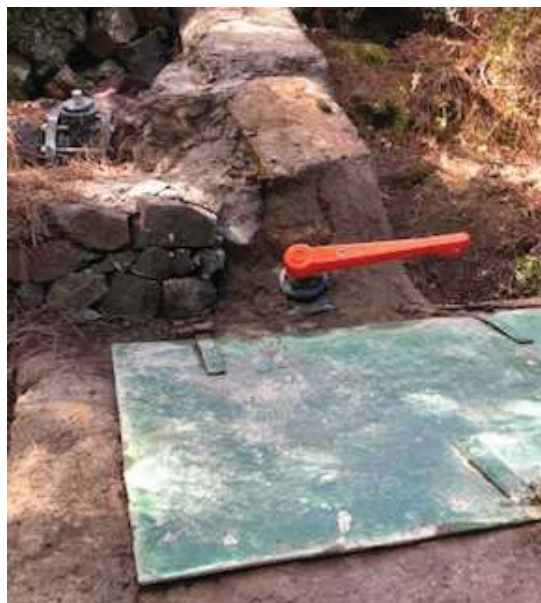
Figura 2-6. Detalle de la entrada de agua a la tanquilla-pesadora
