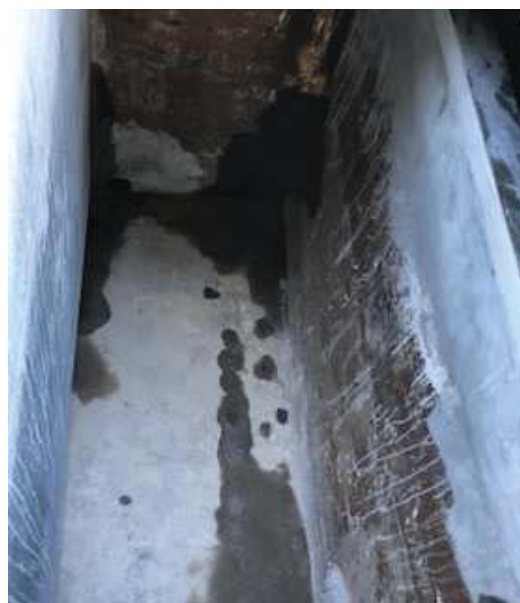
Figura 2-8. Detalle del segundo compartimento de aforo y del vertedero de la tanquilla
